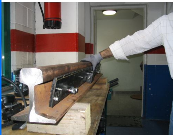
Вид смонтированной шины с второстепенным распределителем
