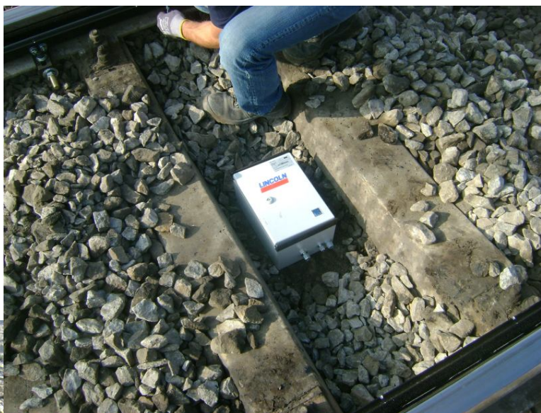
Установка защитного шкафа с главным распределителем
