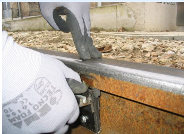
Монтаж крепления шины
