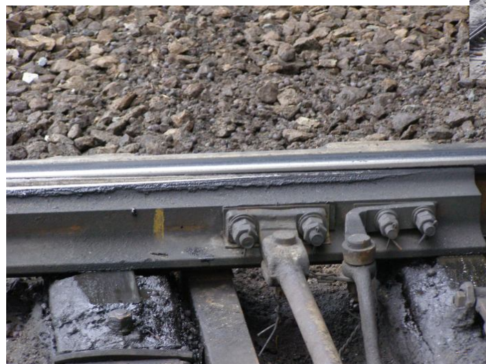
Разнос смазки на стрелочных переводах
