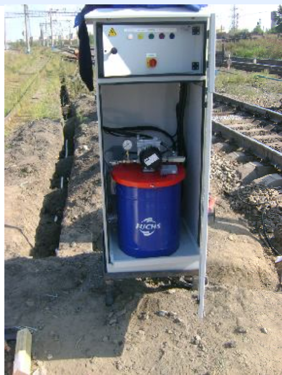
Установка насосной станции в сборе
