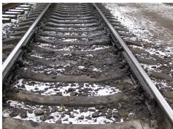
Рельсосмазыватель после годовой эксплуатации
