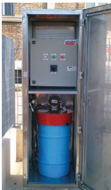
Смазочный насос с блоком управления
